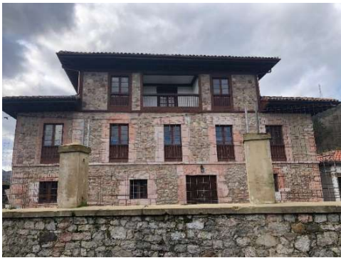
Fachada ppal. de la casona
